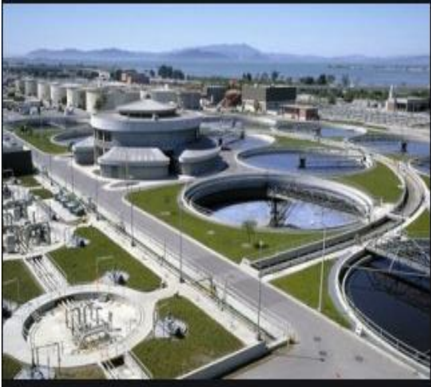
Fuente: PTAR Atotonilco
